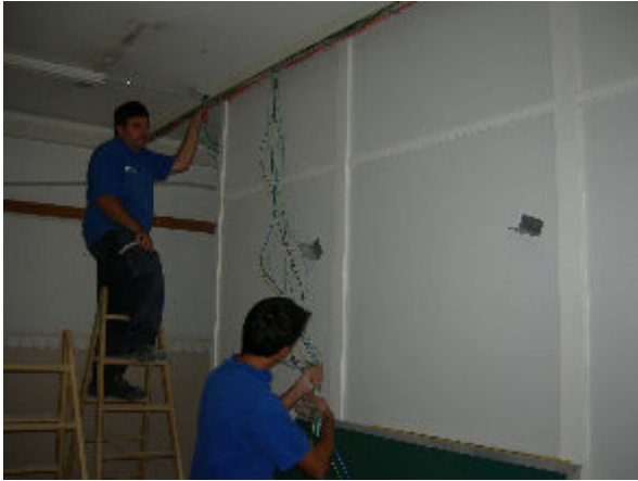
Cableado del centro y reformas en la instalación eléctrica
