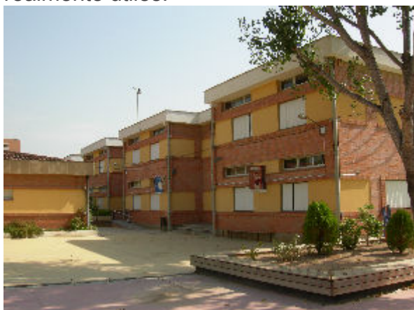
Edificio de primaria
