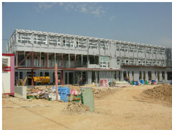
Nuevo edificio de secundaria
